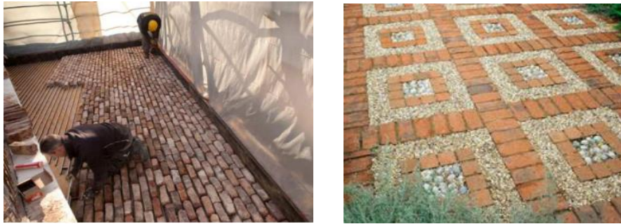
Figura 43. RCD de Ladrillos. Reutilización como baldosas.
