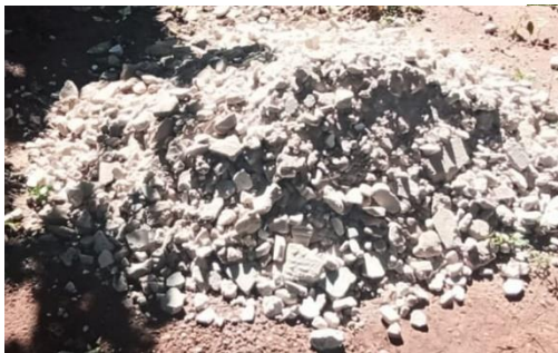
RESTOS DE LADRILLOS
